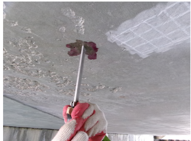
탄산화깊이 측정 현황
